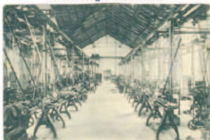
Reparto Torneria Istituto Montani
