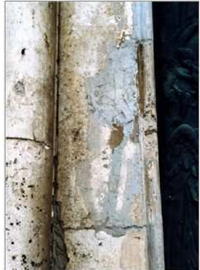
Stuccature con malta di cemento
