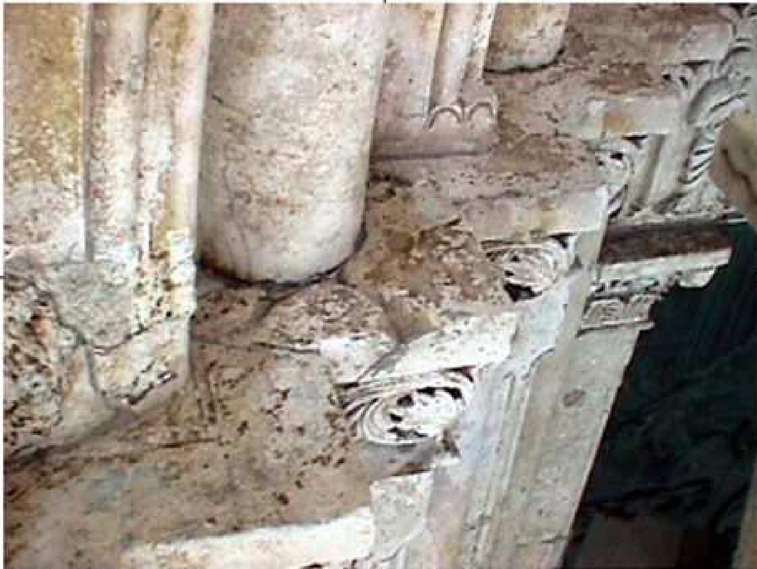
Particolare degli archi strombati
