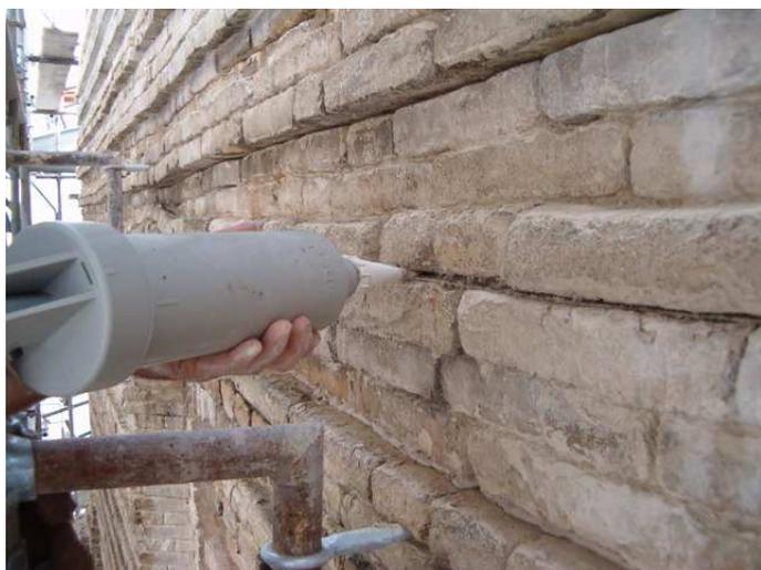
Al fine inoltre di migliorare il comportamento scatolare della struttura sono stati posizionati sugli angoli nastri fibre di acciaio zinco galvanizzato ad altissima resistenza (UHTSS), analogo materiale è stato inoltre collocato esternamente all'interno dei giunti di malta per una fascia sommitale di mt 1.20.
