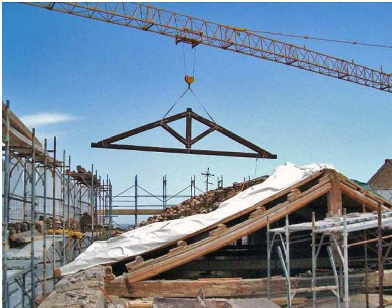
La copertura esistente costituita nelle navate laterali da elementi lignei a semplice orditura e nella navata centrale da capriate di luce pari a circa 11 mt, è stata interamente sostituita in quanto le relative sezioni resistenti non erano conformi alle “*nuove norme tecniche per le costruzioni*” (DM 14/01/2008). Ovviamente l'intervento non ha comportato alcuna modifica dello schema statico nè della linea d'imposta e di colmo.
