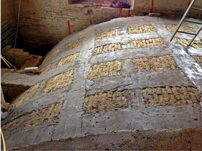
Reso il sottofondo scevro da polvere, efflorescenze saline, muffe e parti incoerenti, è stata applicata una prima mano di betoncino strutturale di calce idraulica, sul quale a “fresco” è stato applicato il tessuto, poi una seconda mano di malta sino al completo inglobamento del tessuto stesso
